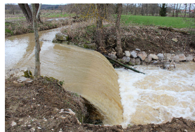
Déversoir latéral sur l'Ill à l'aval de Fislis (68) - Pascal Finaud-Guyot©
