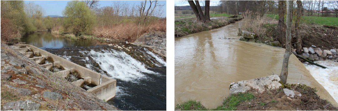
(a) Seuil frontal sur l'Ill (68). On notera en rive droite la présence d'une passe à poisson. (b) Déversoir latéral sur l'Ill à l'aval de Fislis (68).
